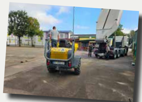
Sanierung der Tennisplätze
