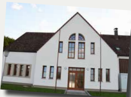
Neue Fassade beim Bauhof
